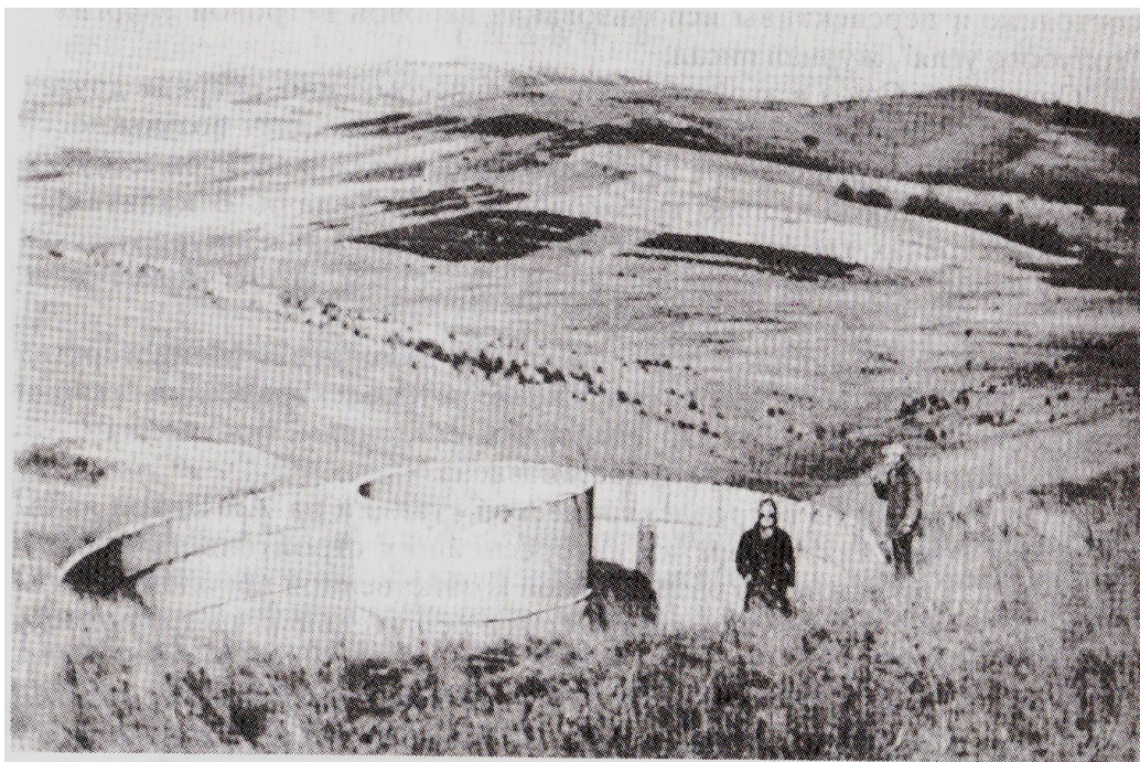
Рис. 20. Опорний стакан під Кримську вітроелектростанцію, встановлений у 1937 р. на Ай-Петрі (фото 70-их років Б.І. Романенка)
