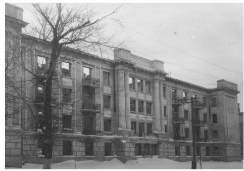
Гуртожиток (теперішній корпус № 3, відбудований у 1952 р.)
