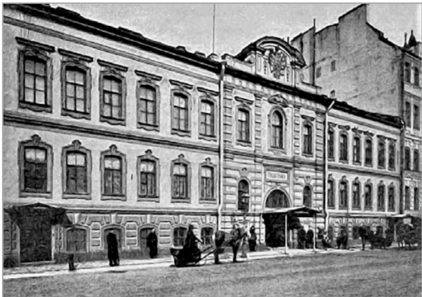
Здание Санкт-Петербургской главной телеграфной конторы.
